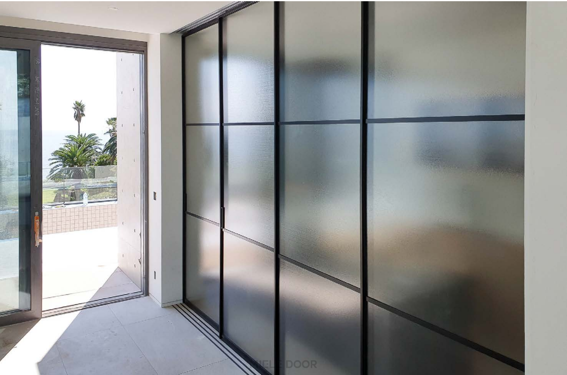
천장 높이 3000mm가 넘는 고급 주거공간 상하부구동 텔레스코픽 4연동 슬라이딩 도어를 적용한 현장입니다.
